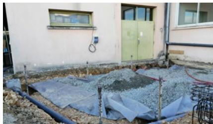
Les travaux d'agrandissement du dojo ont démarré mi-novembre 2021 pour une durée de 4 mois environ. Les travaux consistent en la réalisation d'un sas d'entrée et d'un espace de stockage du matériel (surface créée : environ 32 m<sup>2</sup>). Au vu des sondages et de l'étude de sol, les fondations sont assurées par des micropieux tubés en partie haute et descendant au bon sol. Le gros œuvre est terminé, la structure bois sera posée prochainement et sera habillée d'un bardage métallique.
