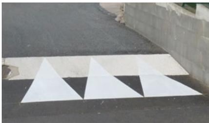
Après les premiers travaux réalisés en 2020, la seconde tranche permettant de finaliser les aménagements de voirie a été réalisée à l'automne 2021 : aménagement de plateaux et de zones de rétrécissement pour limiter la vitesse ; création d'espaces verts sur l'ensemble du secteur et d'un parking de 17 places à côté des logements OPHIS, face au cimetière.
