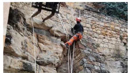
Un danger a été signalé sur une paroi rocheuse, à l'aplomb d'une habitation et en bordure immédiate du sentier des grottes à Enval. Quatre compartiments instables avaient été identifiés dans le cadre du diagnostic de stabilité réalisé en avril 2021 par le bureau d'études Hydrogéotechnique.
