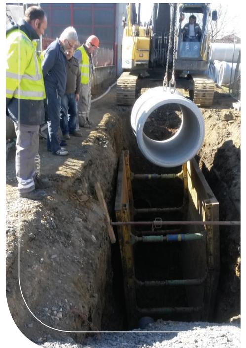
Rue Michel Couturier : pose de réseaux de la canalisation d'eaux pluviales d'1 mètre de diamètre. La municipalité remercie les riverains de leur compréhension pour la réalisation de ces travaux indispensables à l'amélioration du fonctionnement de la station d'épuration, mais aussi de la qualité des eaux rejetées dans l'Allier, la sécurité de la circulation et l'embellissement du quartier.
