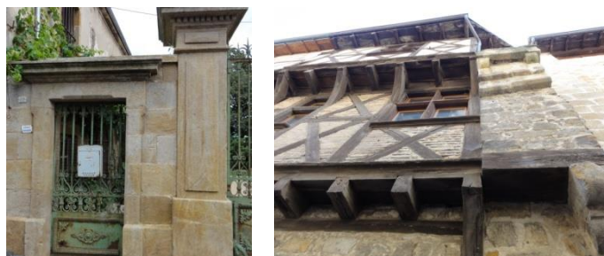
Structure en pans de bois et remplissage de brique.
