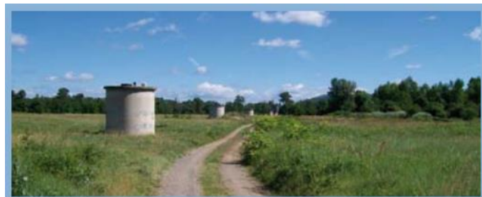
▲ Puits de captage de l'Allier
