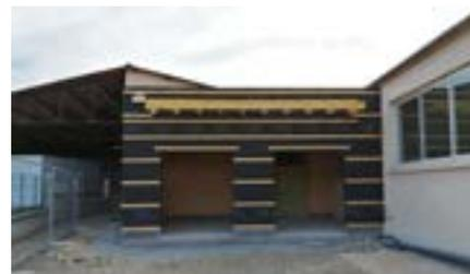
L'ossature bois et les menuiseries extérieures ont été posées en début d'année. L'aménagement intérieur de cette extension composée d'un hall d'entrée et d'un local de rangement est en cours (isolation, habillage des murs, électricité).
