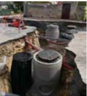
Les travaux de mise en séparatif du réseau d'assainissement ont démarré courant mars sur le secteur de la Croix du Vent. Ces travaux sont réalisés en partenariat avec le Syndicat Mixte de la Vallée de la Veyre et de l'Auzon (SMVVA) qui a la compétence « assainissement » sur
